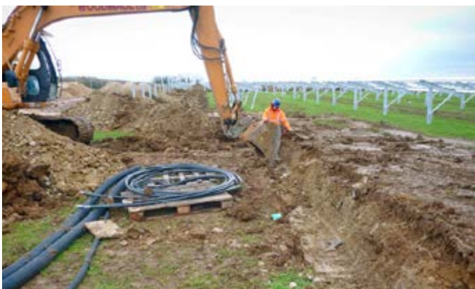
Ausheben von Kabelgräben und die entsprechenden Fundamentarbeiten für die Trafostationen.
